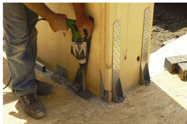
Fig. 3: Hold-down sugli spigoli dell'edificio ed in corrispondenza delle aperture, di presidio al sollevamento.
